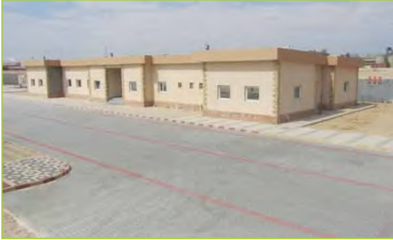
رصف الشوارع انترلوك ٦ - ٨ سم
